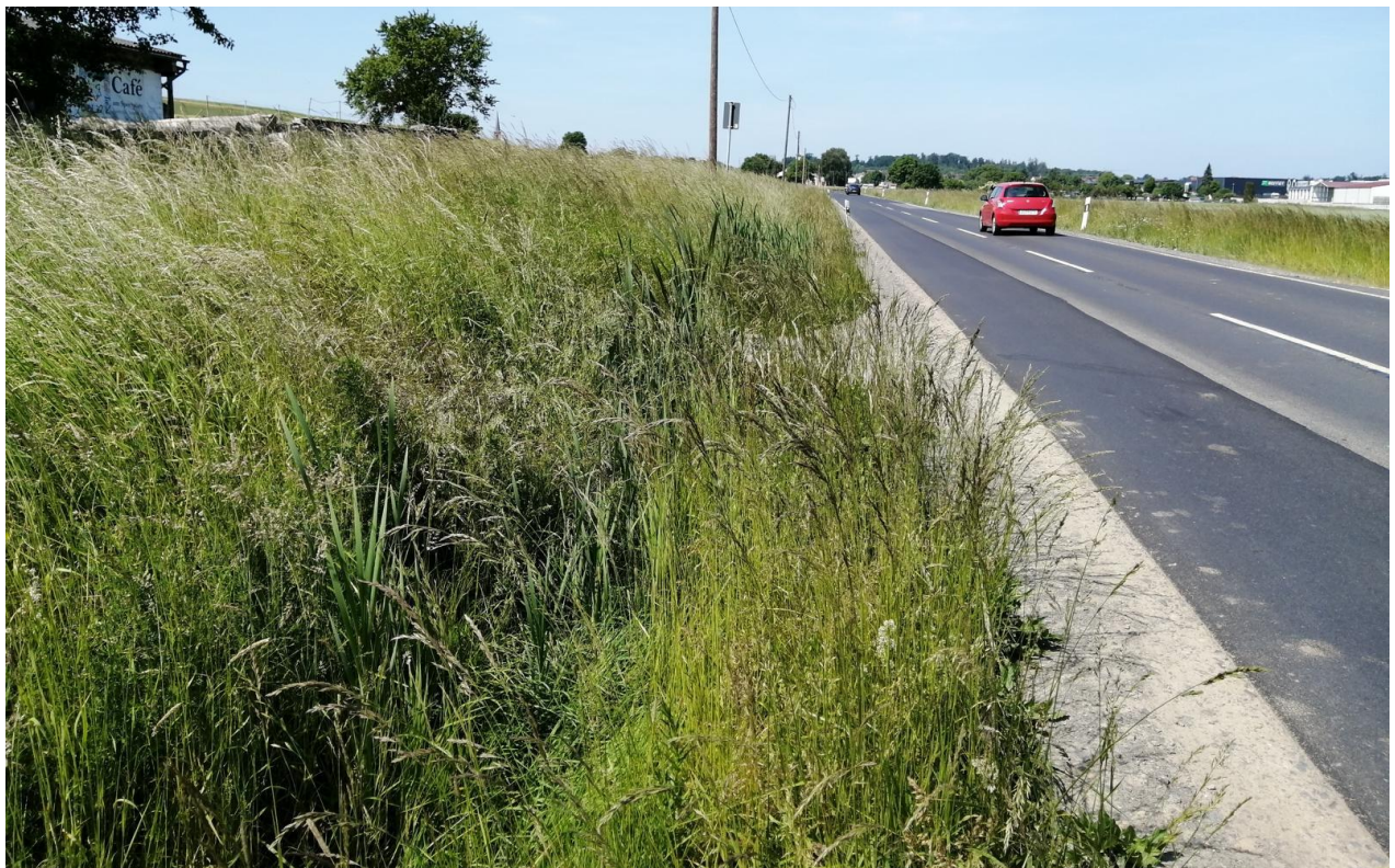
Feuchtbereich mit winzigem Röhrichtbestand im Straßengraben und neu hergestellte Bankettstreifen
