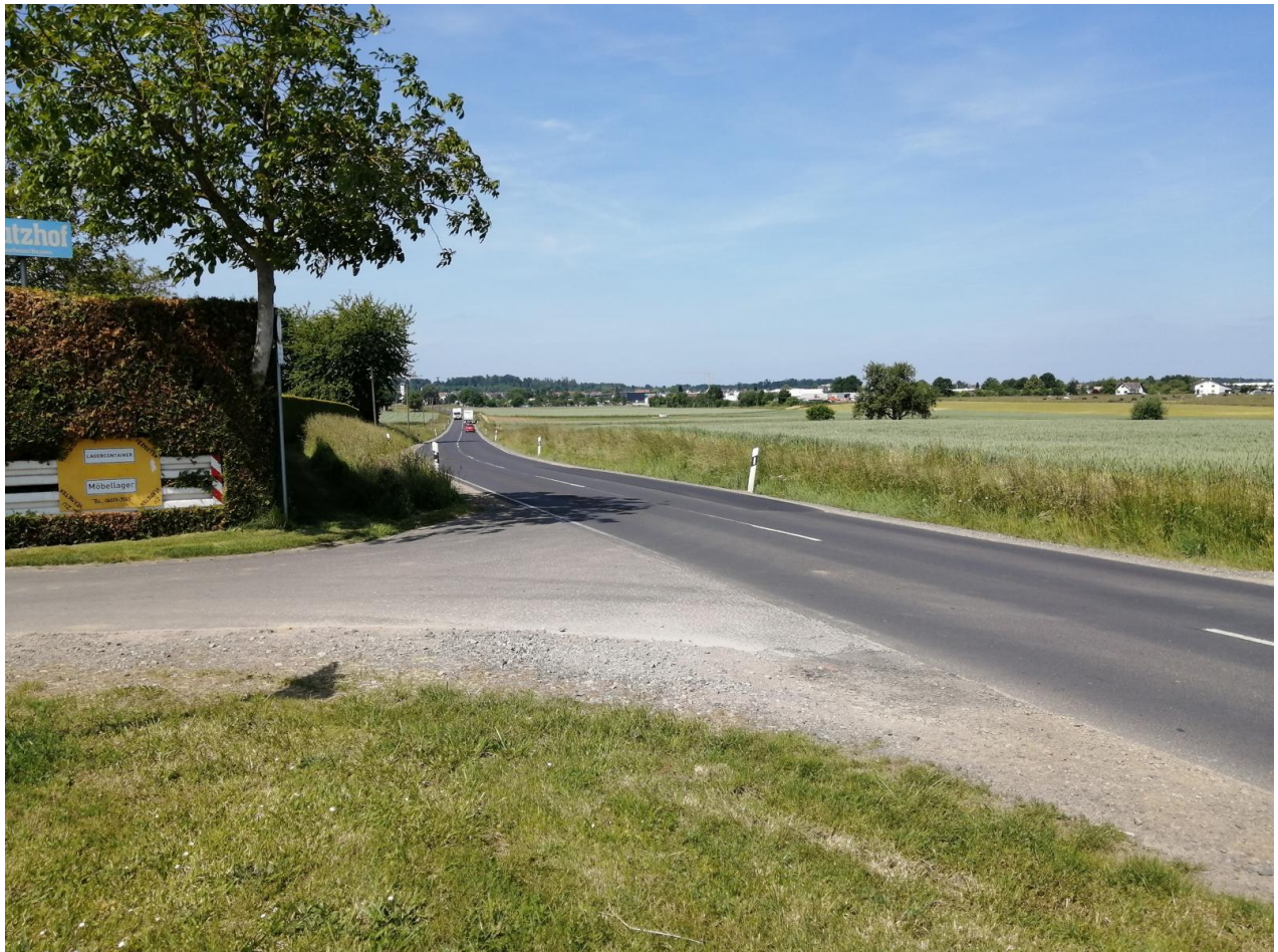
Blick Richtung Westen auf den Stutzhof mit Böschungsbereichen
